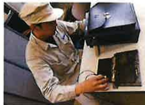
⑦非破壊検査
